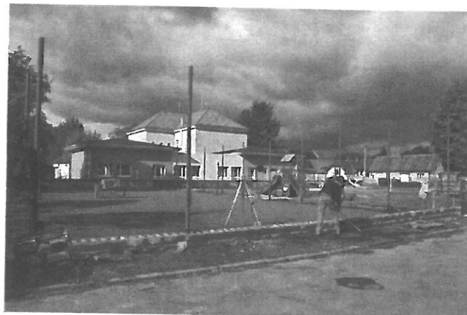
stavba nového plotu u Tenisového kurtu
